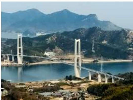
まもなく開通する岩城橋
