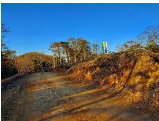
造成中 4号風車道路
